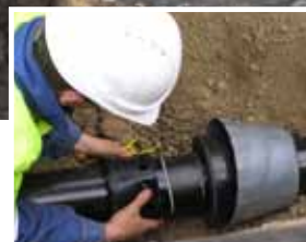
L'éclateur a permis la pose sans tranchée sans intervention mécanique ni humaine dans la zone humide.
