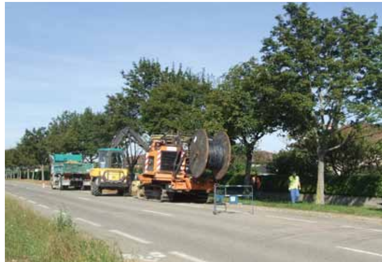
La route départementale RD 148 a été rapidement libérée grâce à la technique de pose mécanisée.
