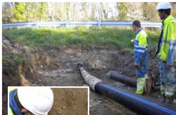
L'éclateur a permis la pose sans tranchée sans intervention mécanique ni humaine dans la zone humide.
