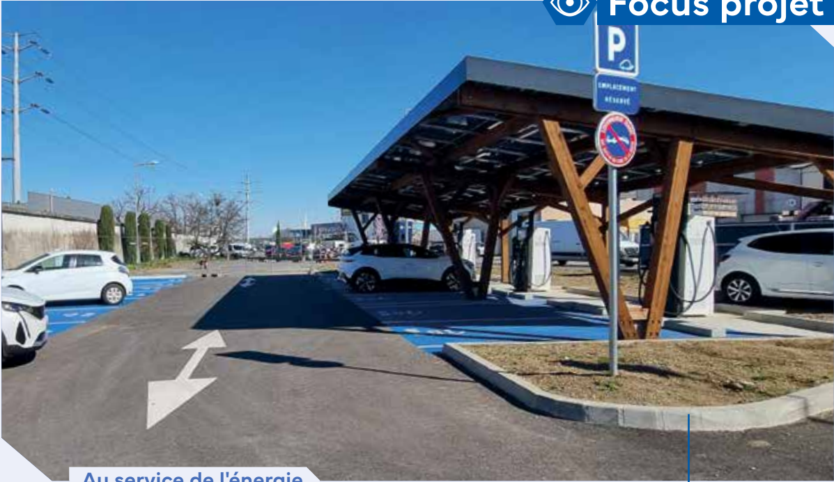
Au service de l'énergie
