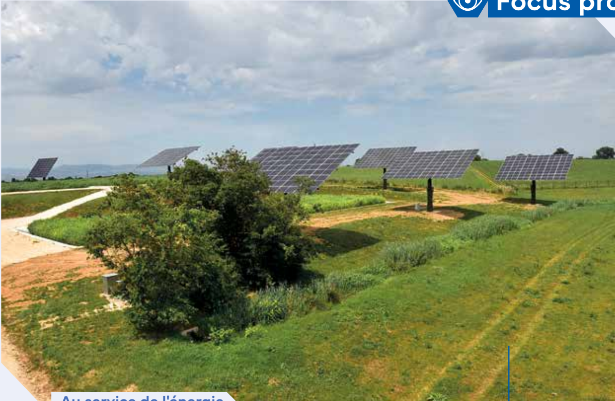
Au service de l'énergie
