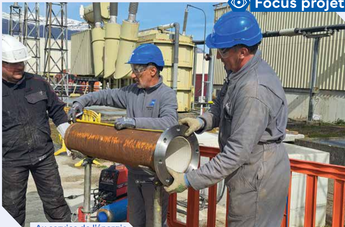
Au service de l'énergie
