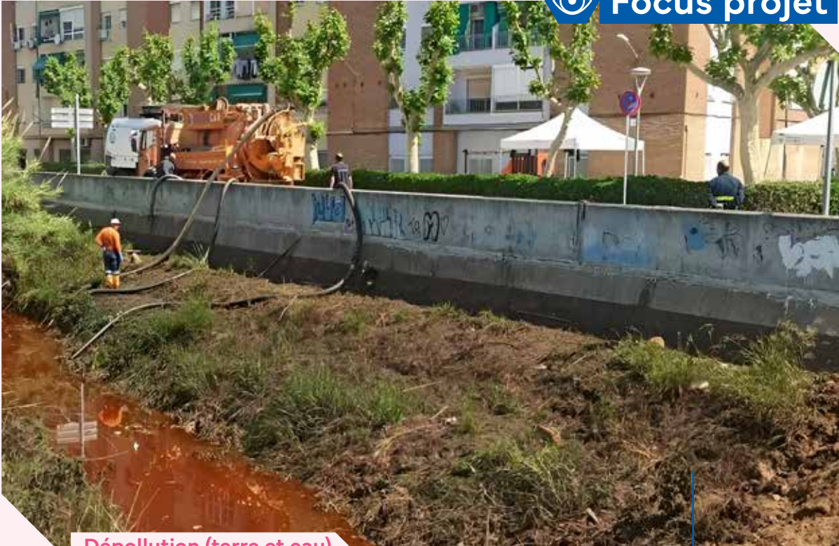
Dépollution (terre et eau)
