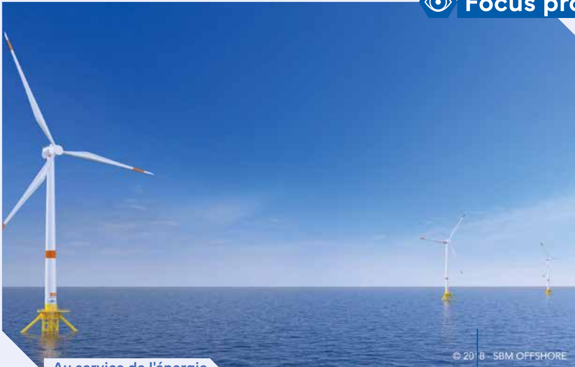
Au service de l'énergie
