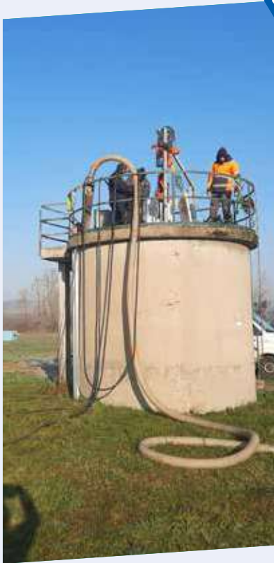
Au service de l'eau
