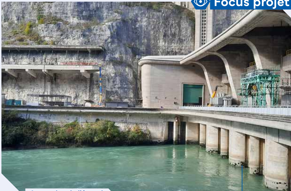
Au service de l'énergie
