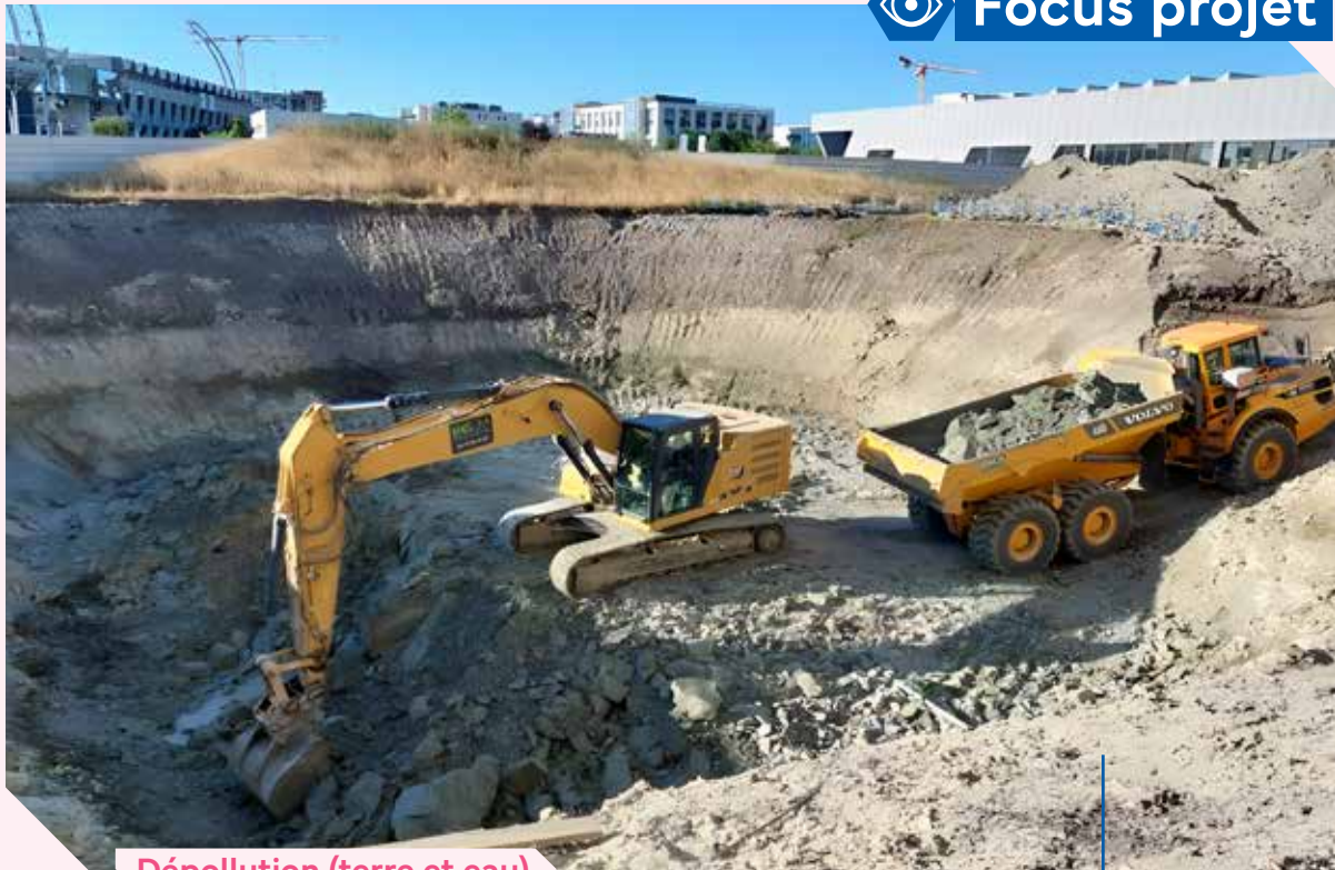
Dépollution (terre et eau)
