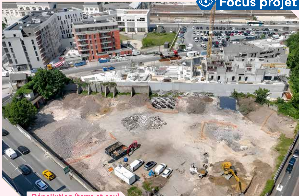
Dépollution (terre et eau)
